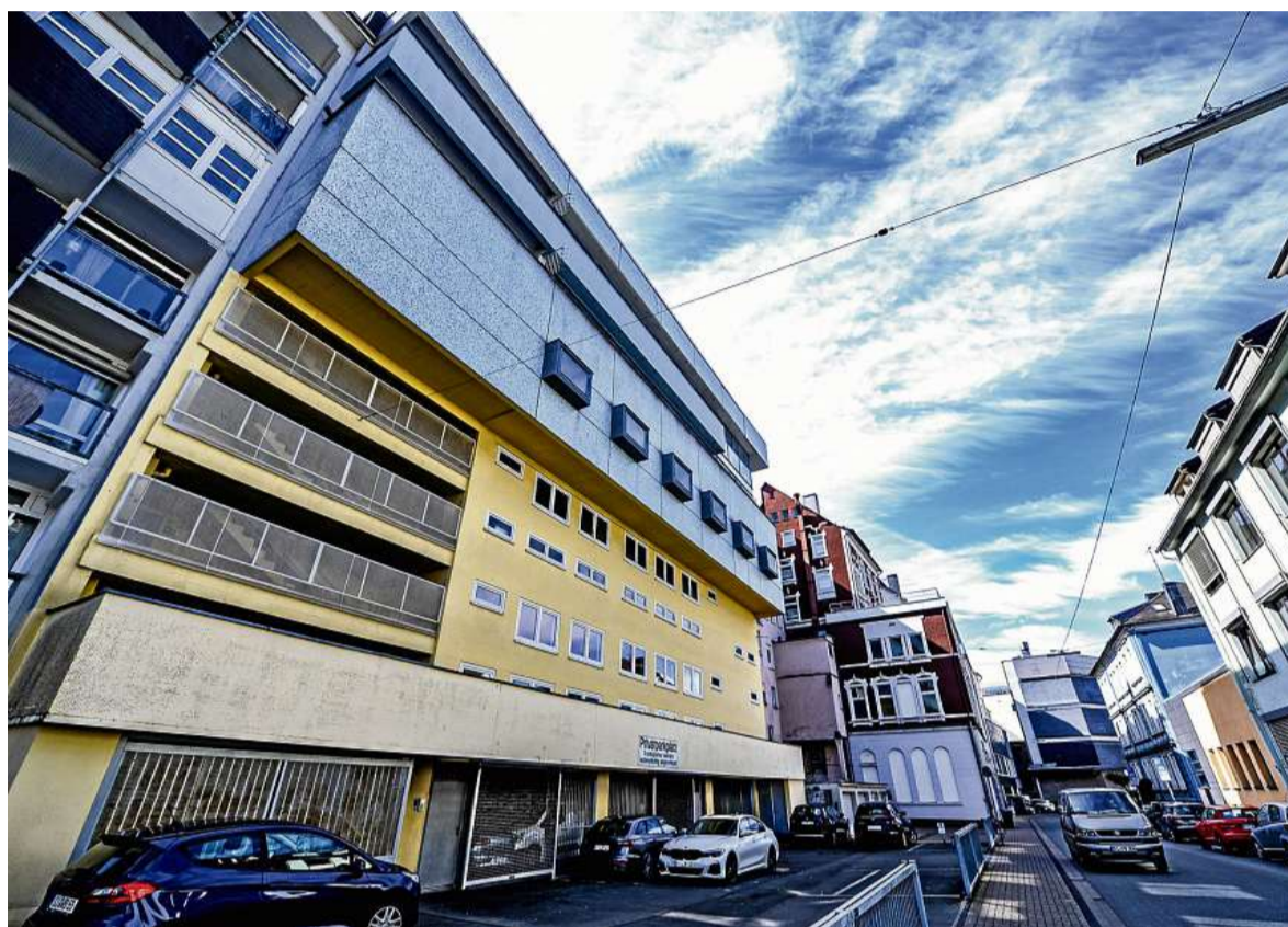
Auf mehreren Etagen reicht das Haus Hettlage von der Friedrichstraße bis zum Niveau Siebergstraße. Hier soll die Universitätsbibliothek einziehen – ob Neubau oder im Bestand, steht noch nicht fest. FOTOS: HENDRIK SCHULZ
